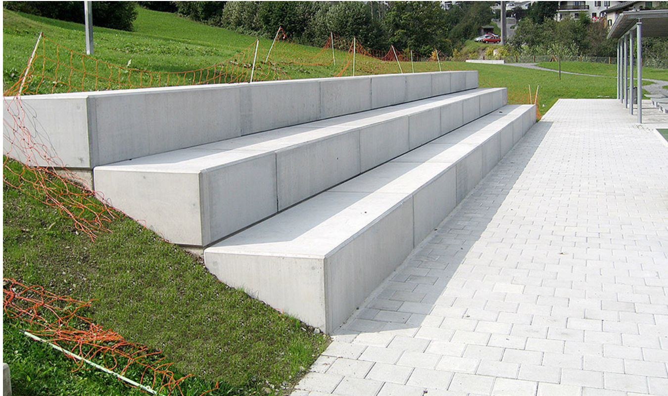
Betonstufen funktionieren als Tribüne
